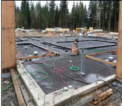
Core Area Ready For Concrete Slab Pour
