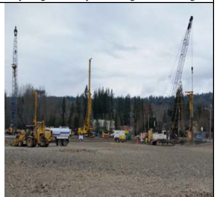
Sm-Crane - Vibro/Cat - Lg-Crane - Holes
