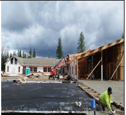
Gymnasium Ready For Concrete Pour
