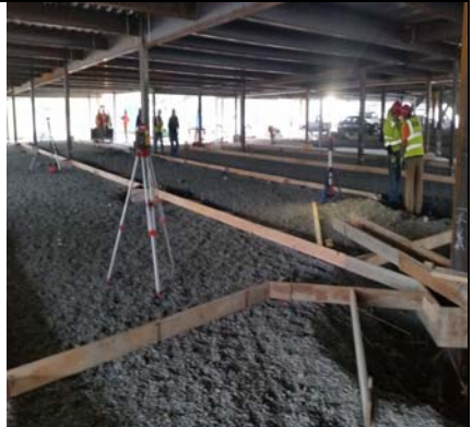
Leveling & Forming For First Garage Pour
