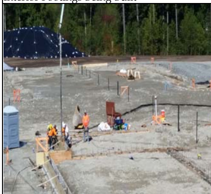
Stem Wall Concrete Pour Begins
